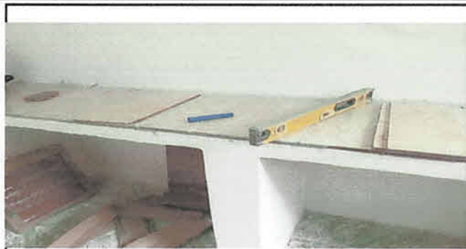
Foto 2: REMOZAMIENTO EN COCINA
