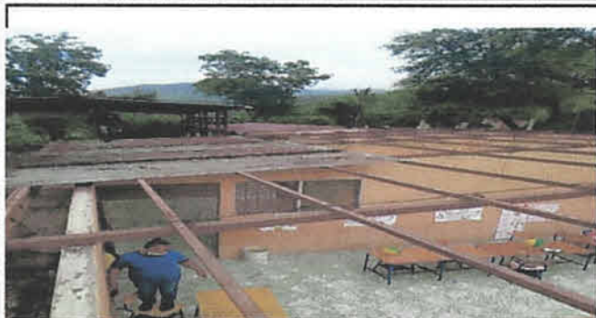
Foto1: CAMBIO DE TECHO DE LAMINA
