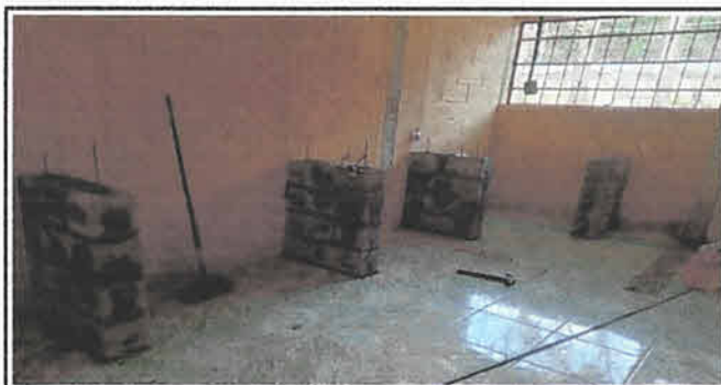
Foto 5: REMOZAMIENTO EN COCINA
