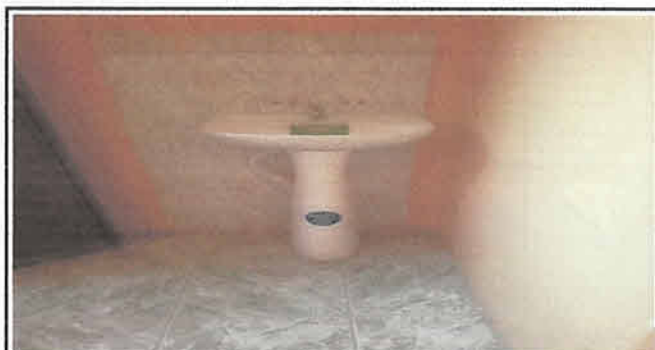
Foto 6: CAMBIO DE BAÑOS
